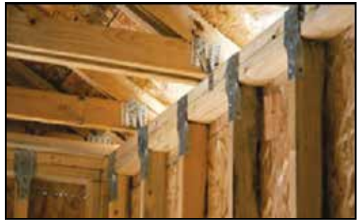
आकृति 3.68: छत और दीवारों के बीच उचित संपर्क (स्रोत: https://www.disastersafety.org/high_winds/making-the-right-connections/attachment/wall-to-roof-straps/ )
