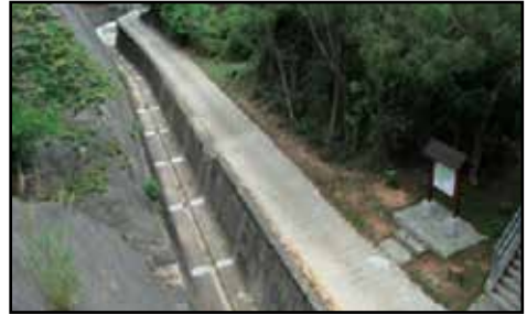
आकृति 3.47: नाली अवरोधन (स्रोत: http://hkbus.wikia.com/i/%E6%AA%94%E6%A1%88:Cheung_Sha_Catchwater_4.JPG )
