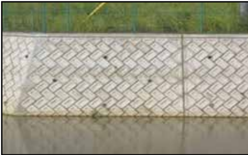
आकृति 3.58: दीवारों में जलनिस्रावक छिद्र (स्रोत: http://construdeia.com/furo-na-parede/ )
