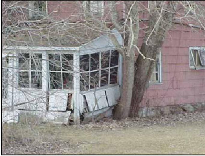
आकृति 3.71 पेड़ की जड़ों के कारण मकान में आयीं दरारें (स्रोत: http://www.guntherhomeinspections.com/ft_foundation_trees.htm )
