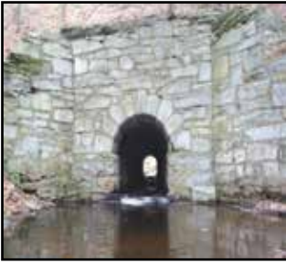
आकृति 3.50: मेहराबनुमा पुलिया आकृति 3.51: सिल्ली नुमा पुलिया आकृति 3.52: पाईपनुमा पुलिया
