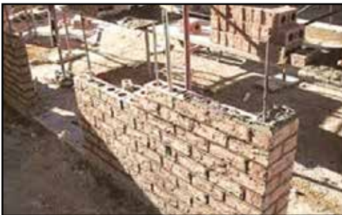
आकृति 3.69: दीवारों के कोनो का सुदृढ़ीकरण (स्रोत: http://blogs.gazette.com/sidestreets/2013/05/03/flashflood-sandbagging-off-to-poor-start )
