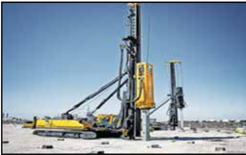
आकृति 3.39: पाइल ड्राइविंग तंत्र (स्रोत: http://theconstructor.org/geotechnical/driven-precast-concrete-piles/7092 )
