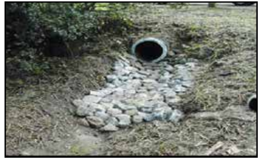
आकृति 3.64: पत्थरों के साथ निर्गम सुरक्षा (स्रोत: http://livestockandland.org/Demonstration_Sites/pilot_site.html )
